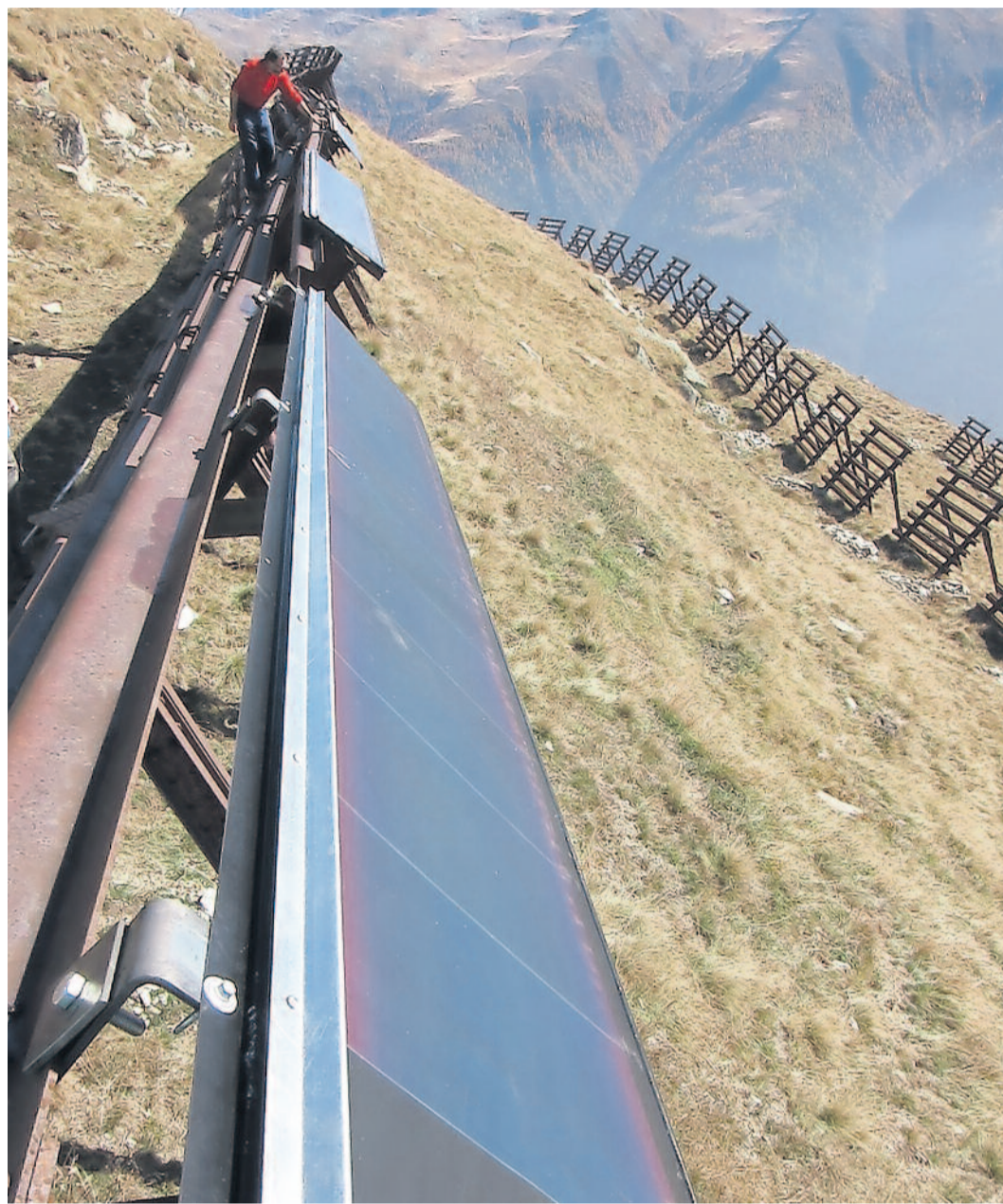
In Reih und Glied. Die Solarpanels entlang einer Lawinerverbauung im Skigebiet von Bellwald.
