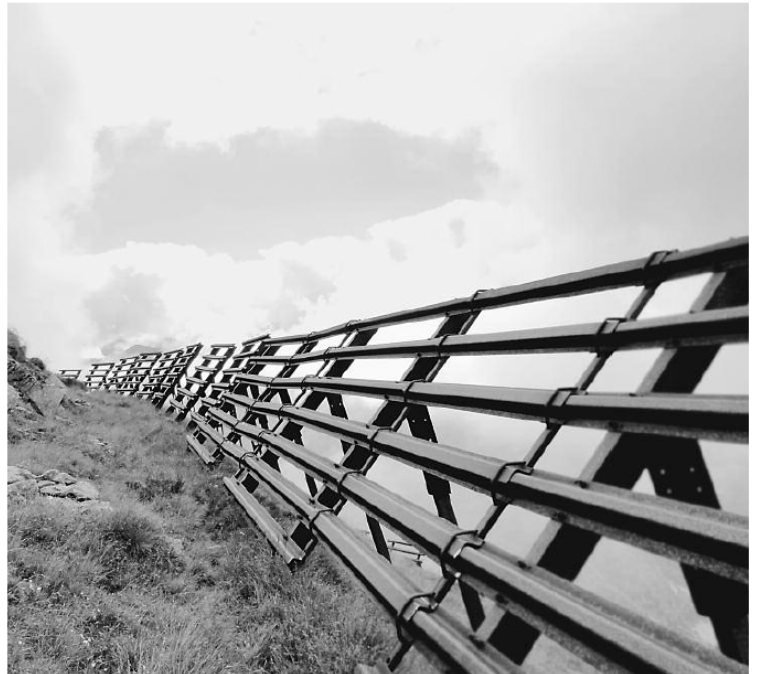
Testphase. Herausfinden, ob sich Lawinverbauungen für die Installation von Fotovoltaikanlagen eignen.
