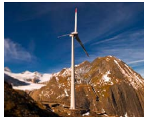
Auf dem Griespass steht bereits eine Windanlage, welche für 800 Haushalte Strom liefert.
